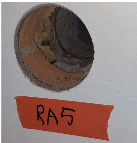
Kuva 10. Rakenneavaus (RA5-MV) ulkoseinälinjan maanvastainen seinä.
