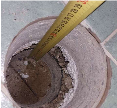
Kuva 8. Alapohjarakenteen rakenneavaus (RA4-AP) suihkutilassa.
