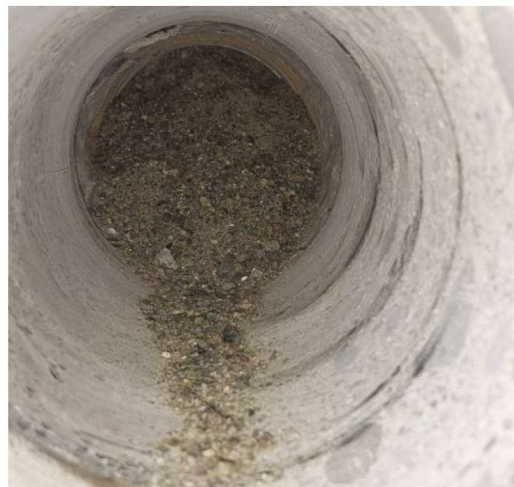
Kuva 25. Rakenneavauksen kautta todettiin sisäpuolisen kuorimuurauksen ja seinän keraamisen laatan olemassaolo. Wc-tila on täytetty hiekalla.
