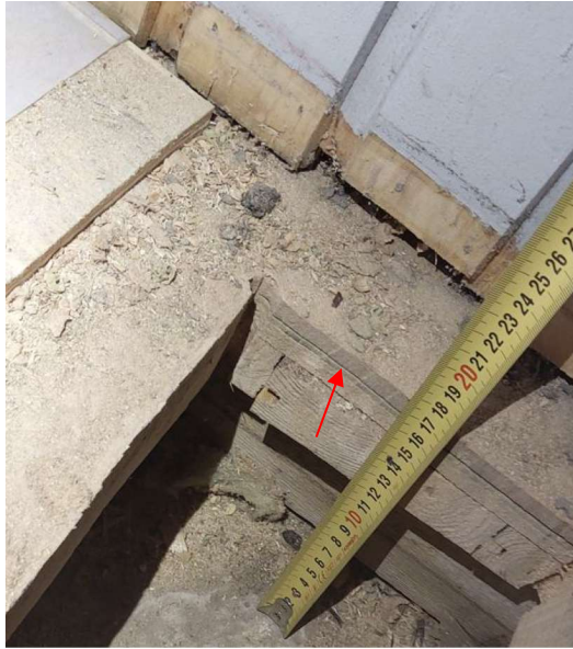
Kuva 16. Pukuhuoneen 139 välipohjarakenteen rakenneavaus RA3. Vihreä muovimattokerros osoitettu nuolella.
