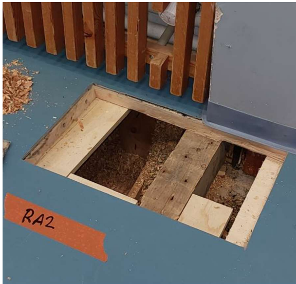
Kuva 6. Salin rakenneavaus (RA2-AP).
