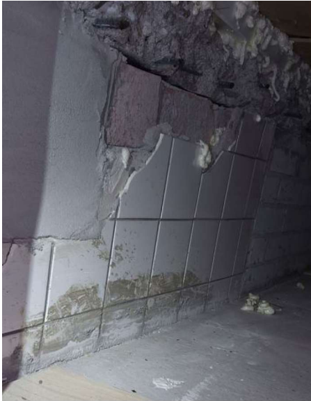
Kuva 22. Näyttämön alapuolisesta tuolivarastosta oli mahdollista ottaa näyte hiekalla täytetyn wc-tilan keraamisesta seinälaatoituksesta ja laasteista (MN3). Näytteessä ei todettu asbestia.
