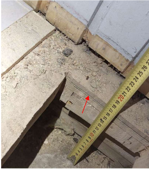
Kuva 16. Pukuhuoneen 139 välipohjarakenteen rakenneavaus RA3. Vihreä muovimattokerros osoitettu nuolella.
