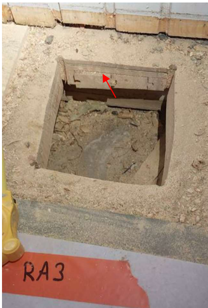
Kuva 12. Välipohjan rakenneavaus (RA3-VP). Punainen nuoli osoittaa vihreää muovimattokerrosta/mustaa liimaa.
