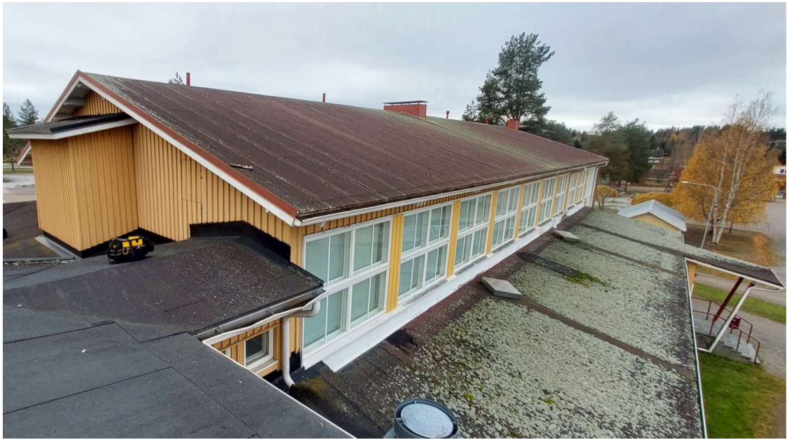
Kuva 3. Yleiskuva rakennuksen vesikatolta.
