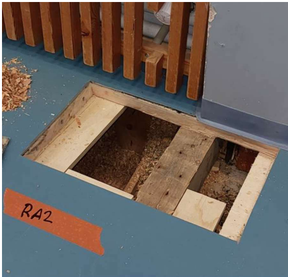
Kuva 6. Salin rakenneavaus (RA2-AP).
