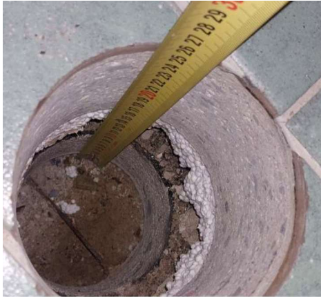
Kuva 8. Alapohjarakenteen rakenneavaus (RA4-AP) suihkutilassa.
