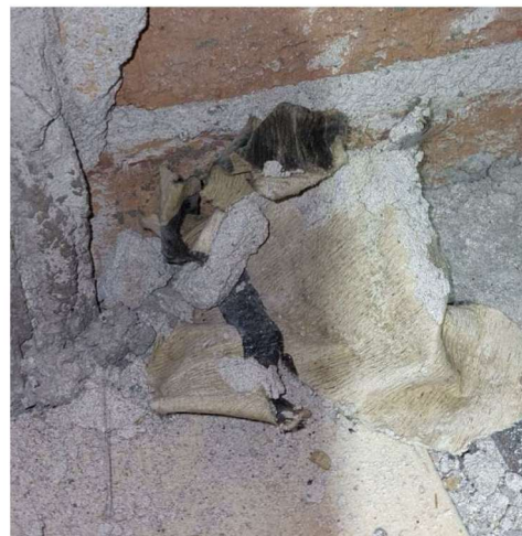
Kuva 21. Bitumoitu valupaperi näyttämön alapuolisessa tuolivarastossa.
