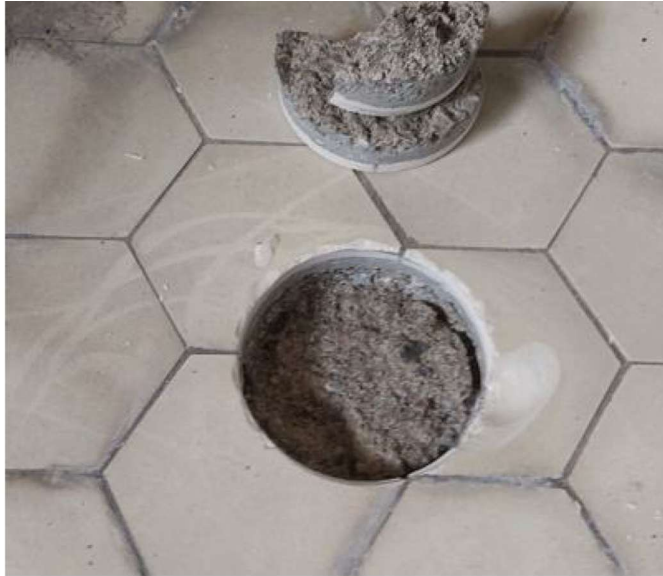
Kuva 23. Varsinaisen koulurakennuksen eteläpäädyssä on vastaava wc-tila 008 kuin näyttämön alapuolinen hiekalla täytetty wc-tila. Wc-tilan 008 keraamisesta lattialaatasta ja laasteista otetussa näytteessä (MN12) ei todettu asbestia.
