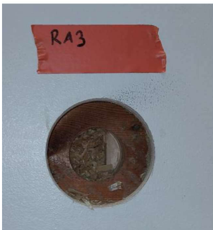
Kuva 9. Rakenneavaus (RA3-US) salin ulkoseinärakenteeseen.
