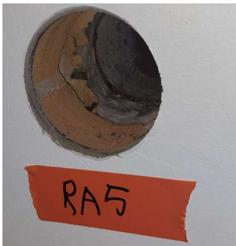
Kuva 10. Rakenneavaus (RA5-MV) ulkoseinälinjan maanvastainen seinä.
