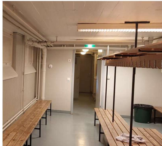
Kuva 5. Yleiskuva pohjakerroksen pukuhuoneesta.
