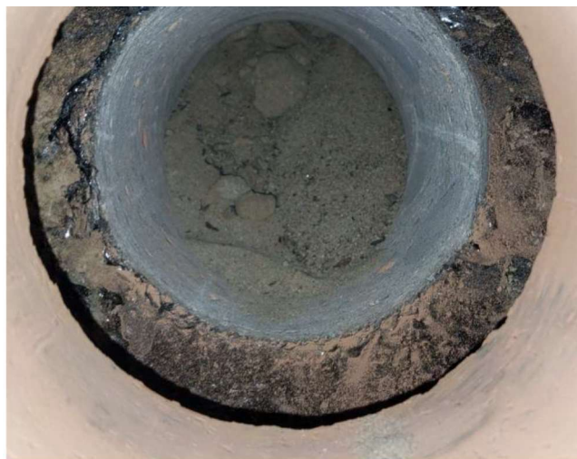
Kuva 11. Rakenneavaus (RA6-MV) salia vasten oleva maanvastainen seinä.
