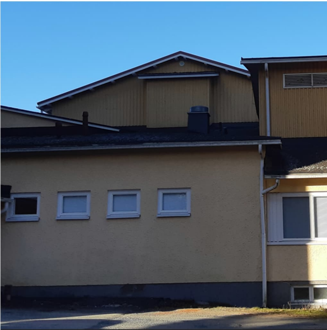
Kuva 3 Purettavat iv-kanavien suojarakenteet
