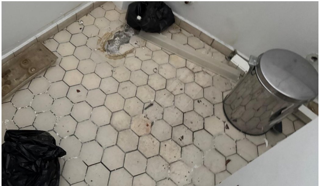
Kuva 13. Vaalea 6-kulmainen lattialaatta + sauma + kiinnityslaasti (näyte 10) eivät sisällä asbestia.
