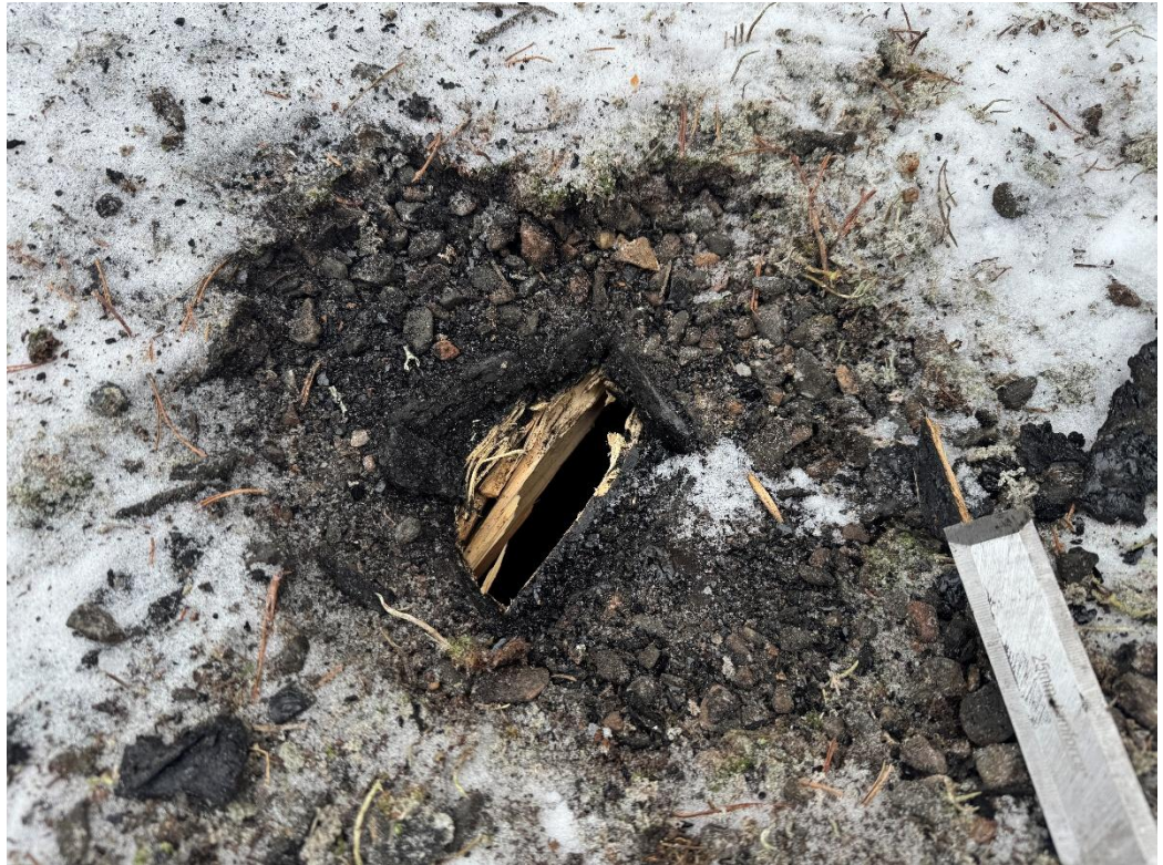
Kuva 18. Vesikaton bitumihuovat (näyte 16) eivät sisällä asbestia.
