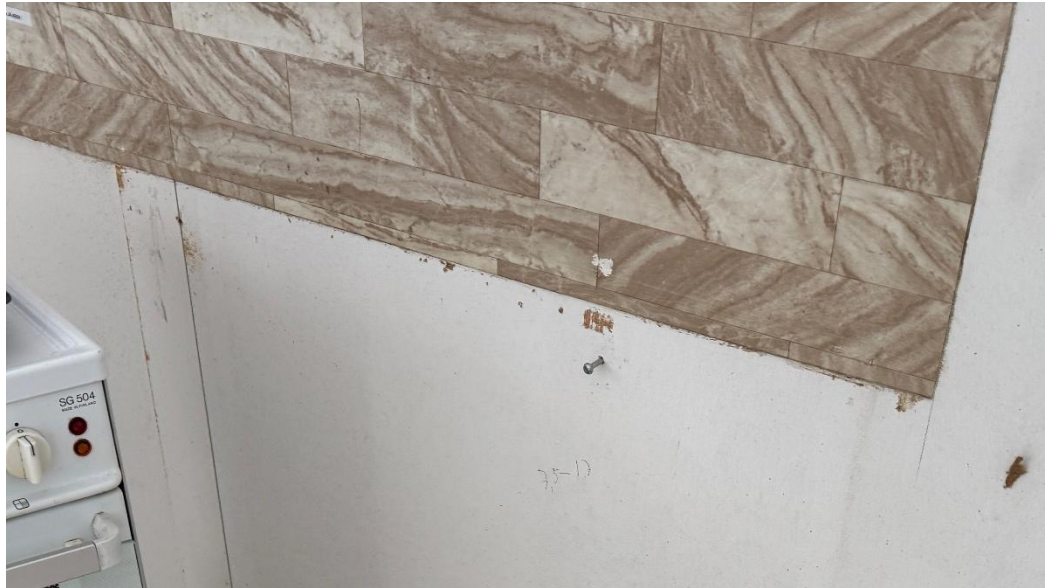
Kuva 10. Seinätapetti parkettikuvioitu (muovi) +liima + maali (näyte 6) eivät sisällä asbestia.
