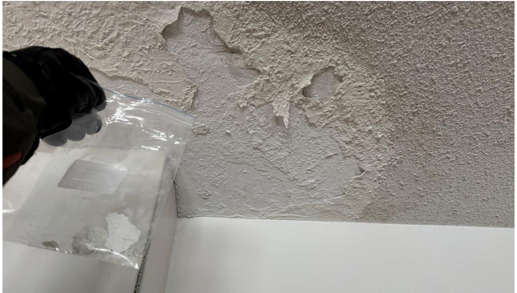
Kuva 12. Kattotasoinne + maalit (näyte 8) eivät sisällä asbestia.
