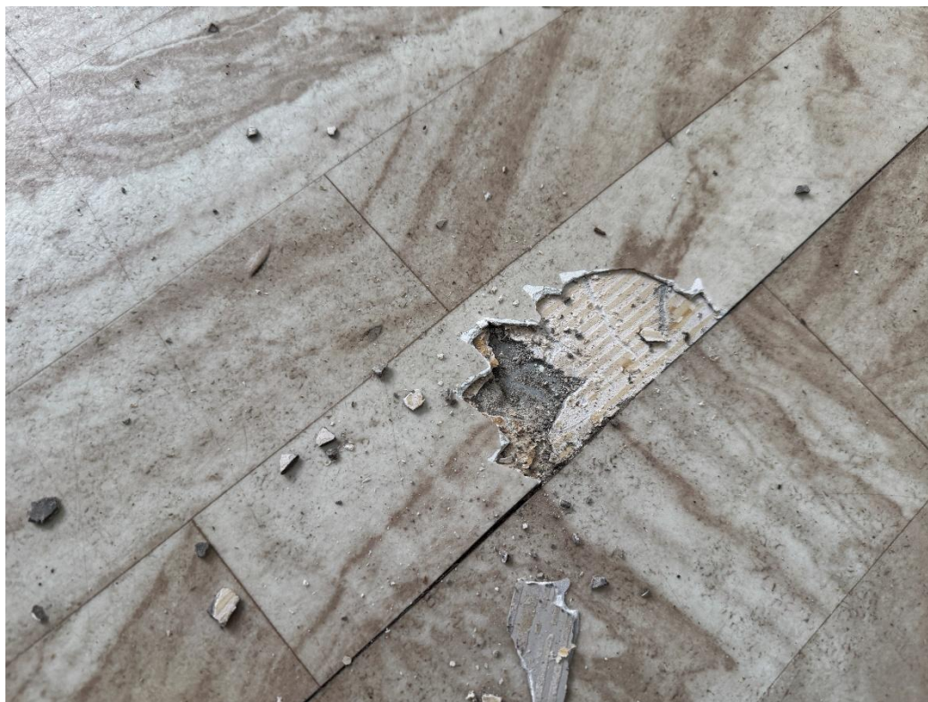
Kuva 5 Vanhan autotallin osalla oleva vaalea puukuvioitu muovimatto +liima +tasoite (näyte 1) eivät sisällä asbestia.
