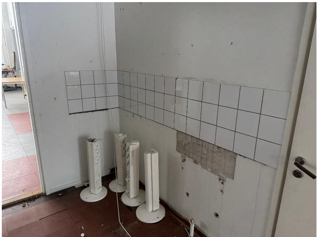
Kuva 11. Seinälaatta valkoinen 150x150 +harmaa sauma +kiinnityслиima + maali+ tasoite (näyte 7) eivät sisällä asbestia.
