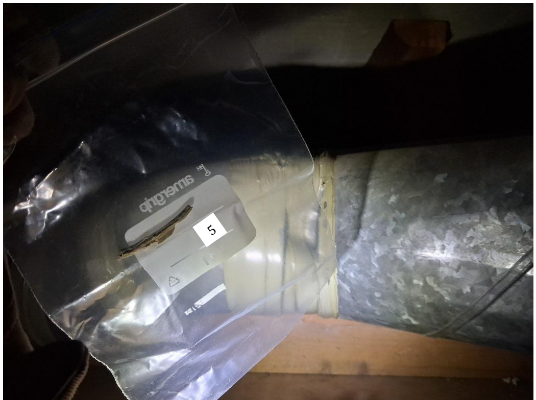
Kuva 9. Ilmanvaihtokanavan tiivistemassa (näyte 5) ei sisällä asbestia.
