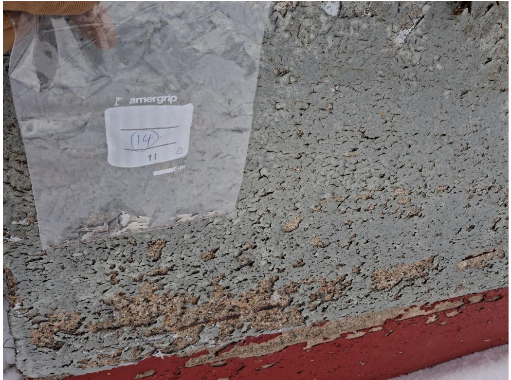
Kuva 16. Sokkelin maalit sinertävä ja vaaleanharmaa (näyte 14) eivät sisällä asbestia.
