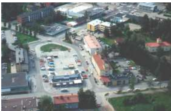
Juuri uudistettu tori v. 1993.
