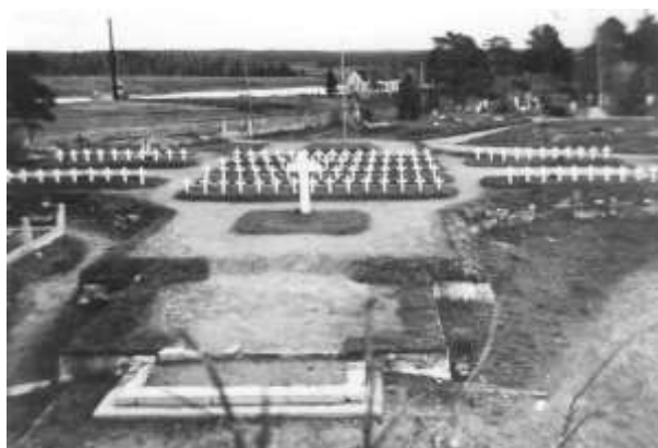
Sankarihautausmaa talvisodan jälkeen. Talvi- ja jatkosodissa katuneet sankarivainajat haudattiin palaneen kirkon kivijalan sisäpuolelle. Sankarihauta-alueen suunnitteli arkkitehtitoimisto Harmia & Baeckman 1946.
