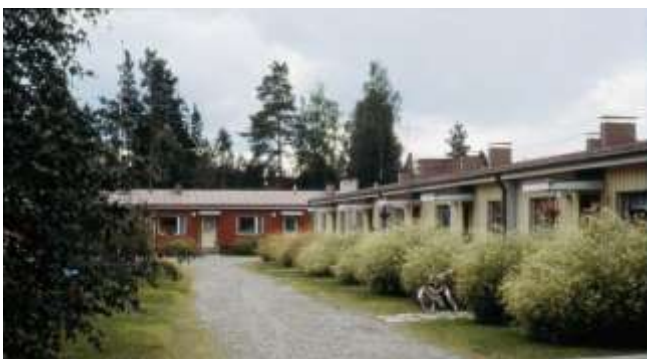
Kirkonkylän ensimmäiset rivitalot rakennettiin Leikkimetsään v. 1966. Matalia, tiilipäätisiä, puuverhoiltuja rakennuksia kattavat loivat harjakatot. Kuva vuodelta 1979.
