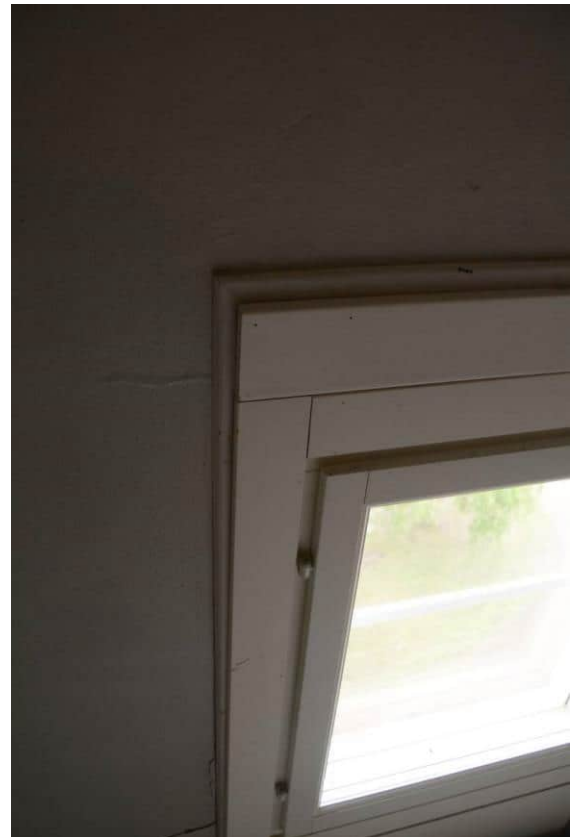
Kuva 109, Ikkunaremontin yhteydessä uudet ikkunat on asennettu vanhojen karmien sisään.
