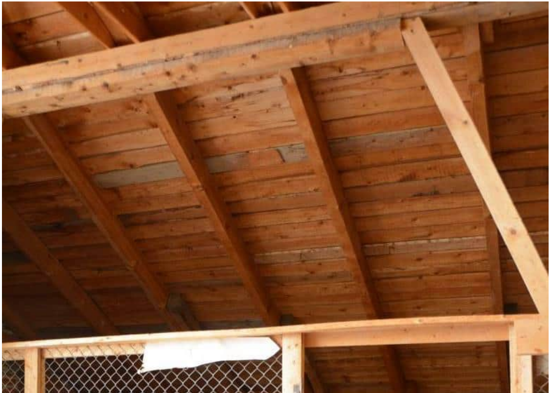
Kuvat 112, Ullakkokerroksen yläpohja. Ullakon lämpötila pysyttelee lähellä ulkolämpötilan lukemia.
