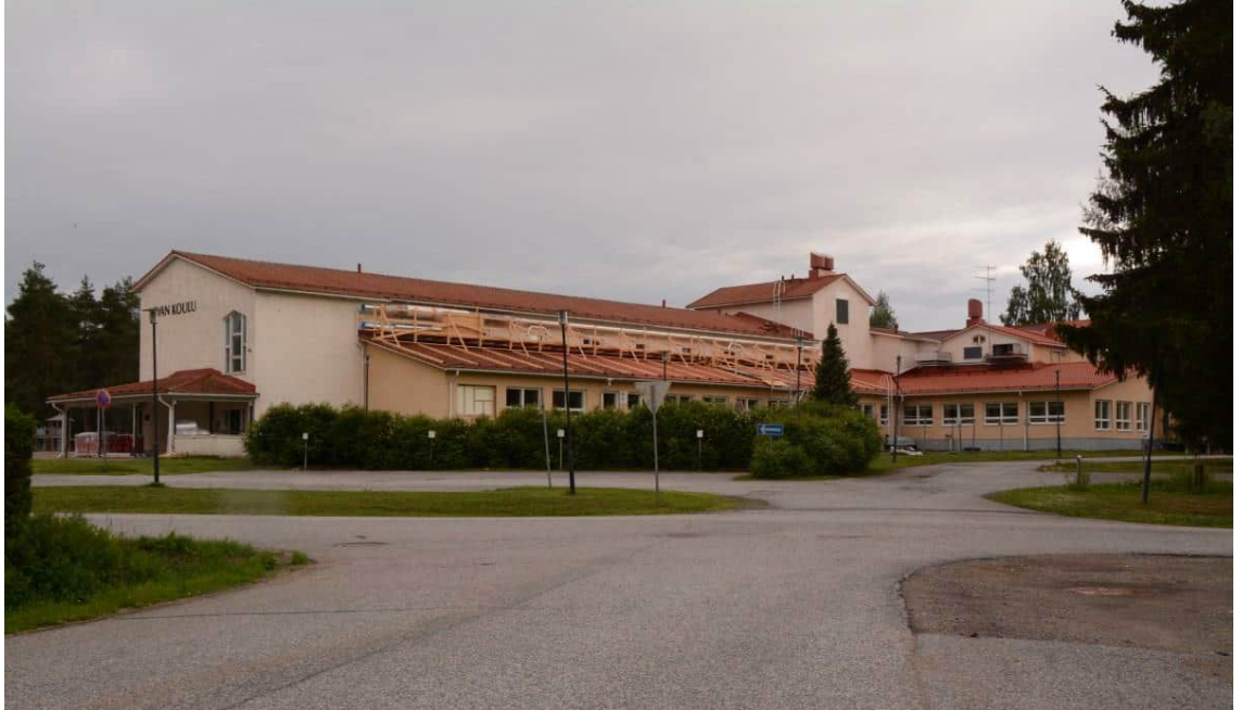
Kuva 41, Nivan koulun julkisivu koilliseen. Etualalla erottuvan laajennuksen (2003–2004) katolla on ilmanvaihdon parantamiseen liittyvät työt käynnissä.
