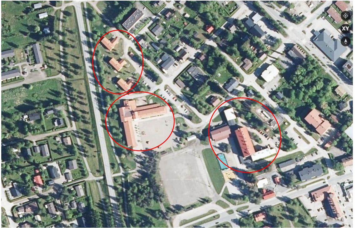
Kuva 3, Ortokuva selvityksen kohteena olevista rakennuksista. Vasemmalla ylhäällä opettajien asuintalot, vasemmalla alhaalla Nivan koulu ja oikealla alhaalla Kiuruveden yläkoulu. Kuvälähde: Paikkatietoikkuna
