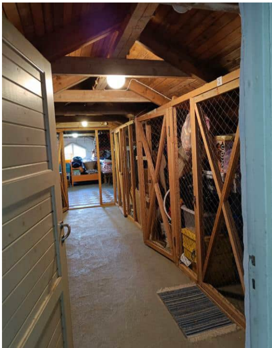
Kuva 77, A-talon ylimmässä kerroksessa sijaitsevat asukkaiden häkkivarastot.
