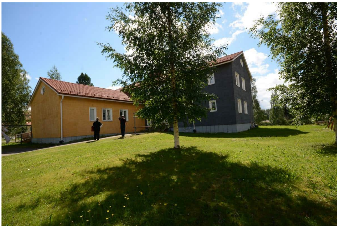
Kuva 67, Rakennus A pohjoisesta kuvattuna.
