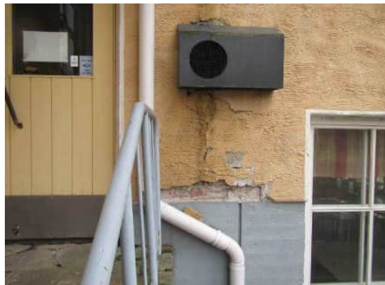
Kuva 120, Julkisivu tilan 028 kohdalla. Kuvälähde: Kiwa Inspecta, 2022.
