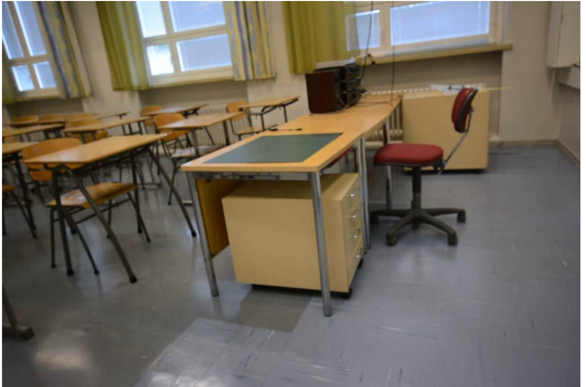
Kuva 106, Luokan opettajien pääty oli alun perin korokkeella. Raja on nähtävissä vihreän 25x25 laatan ja 30x30 hovi-vinyylilaatan rajalla. Koroke on todennäköisesti poistettu vuonna 1994 sisäkorjausten yhteydessä.
