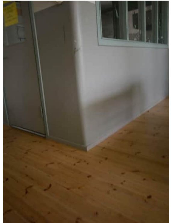
Kuva 61, Teknisen työn luokassa alkuperäinen - puulattia ja 50-luvun pyöristettyjä kulmia.
