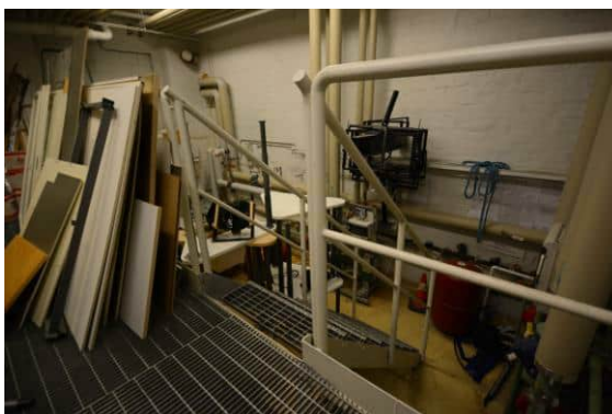
Kuva 64, Alakerran lämmönjakohuoneen seinästä on edelleen erotettavissa umpeen muurattu luukku, josta alun perin on syötetty rakennukseen halkoja.
