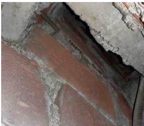
Kuva 135, Luokkatilan 324 hormi vaikuttaa olevan auki yläpohjaan päin. Kuvälähde: Kiwa Inspecta, 2022.
