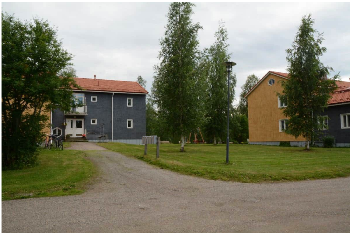
Kuva 66, Rakennukset A ja B kuvattuna idästä.
