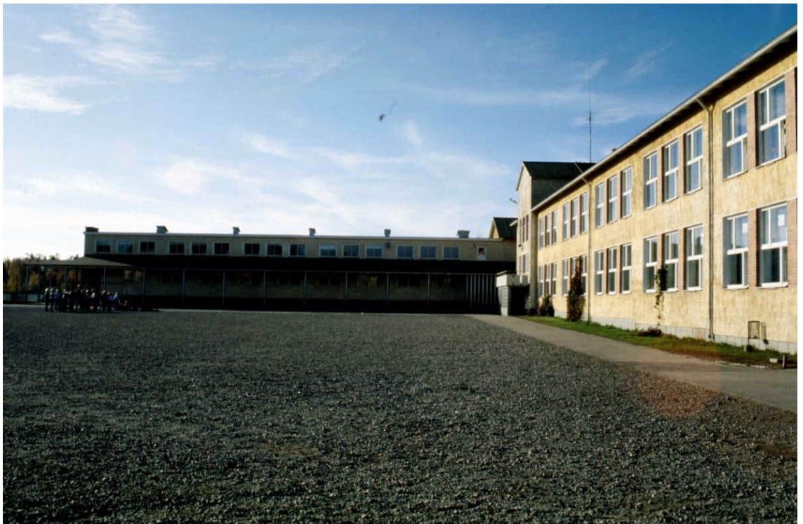
Kuva 24, Nivan ala-aste vuonna 1985. Kuvälähde: Kiuruveden kaupunki, kuvaaja ei tiedossa.
