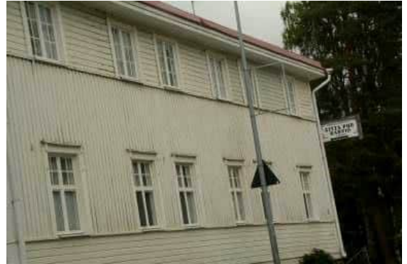
Kuva 10, Puurakentamista Niemistenkadun varrelta.
