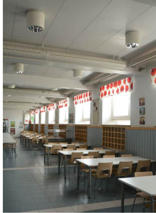
Kuva 103, Rakennuksen keskiosan 0.kerroksessa sijaitsevat ruokalan tilat.
