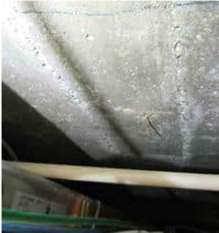
Kuva 126, Rakennuksen yläpohjassa puukappaleita/-rimoja.
