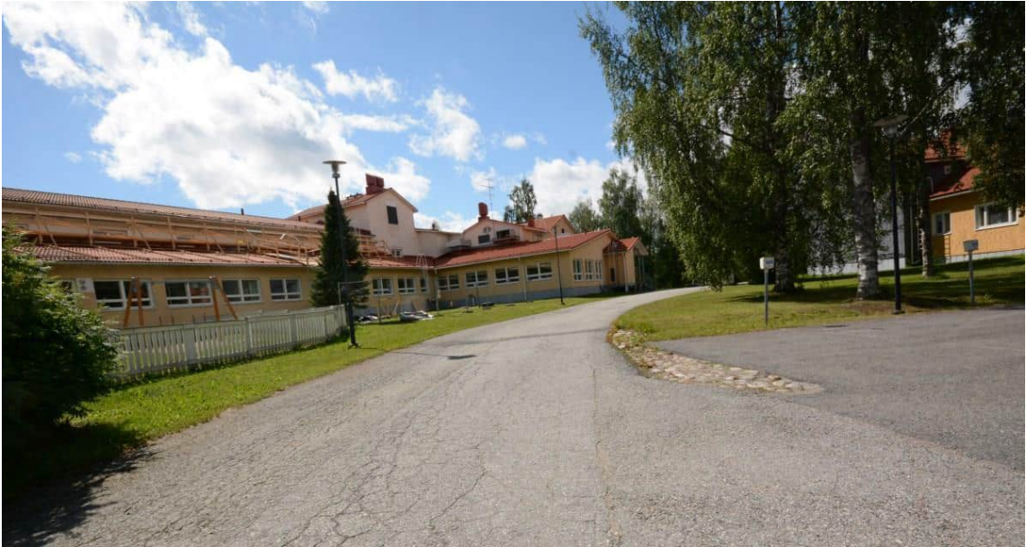
Kuva 25, Nivan koulu kuvattuna koillisesta heinäkuussa 2024. Julkisivun etualalla erottuu matalampana yksikerroksisena rakentamisena vuoden 2003 laajennusosa.
