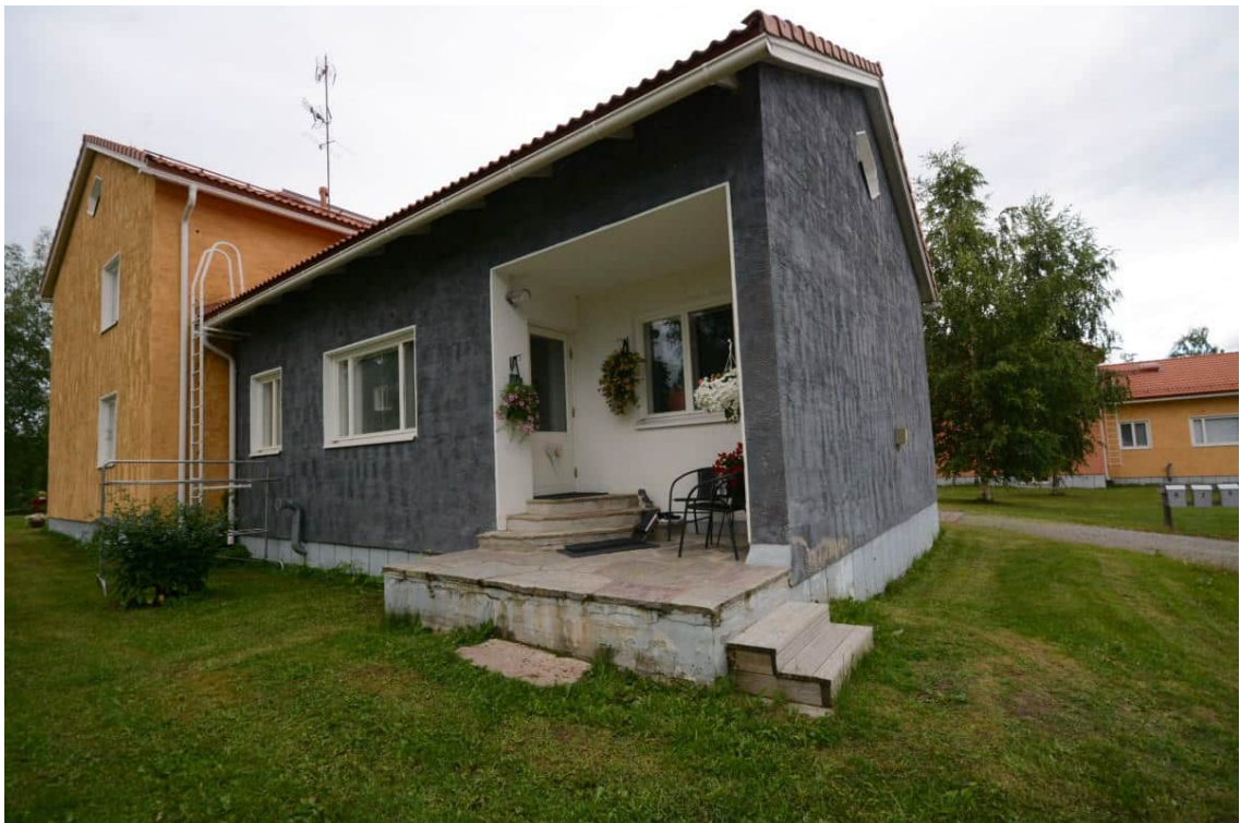
Kuvat 71, Rakennusten kaakkoissivuilla on sisennetyt kuistit, joita osa asukkaista käyttää asuntojensa yksityisinä pääsisäänkäynteinä. Asuntoihin on käynti myös rappukäytävän kautta.
