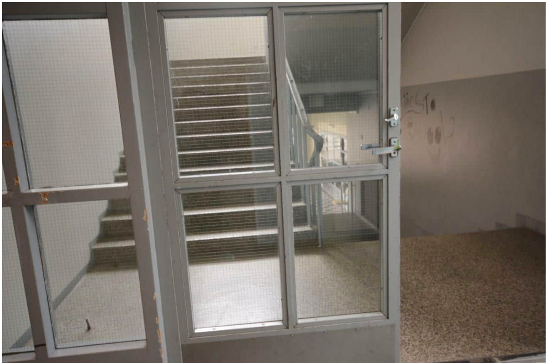
Kuva 101, Vuoden 1994 remontissa vaihdetut lasiovet palo-oviksi.
