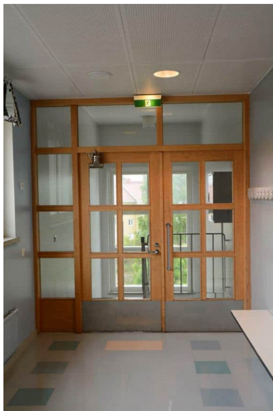
Kuva 113 ja 114, Eteläsiiven alkuperäisen oven pumppu toimii hyvin edelleen tänä päivänä.
