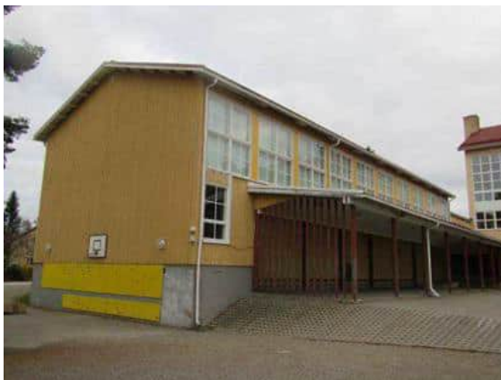
Kuva 131, Vanhan voimistelusalin lautaverhottu julkisivu. Kualähde: Kiwa Inspecta, 2022.
