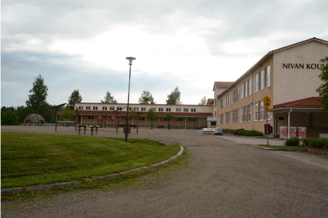
Kuva 39, Nivan koulun julkisivu itään.
