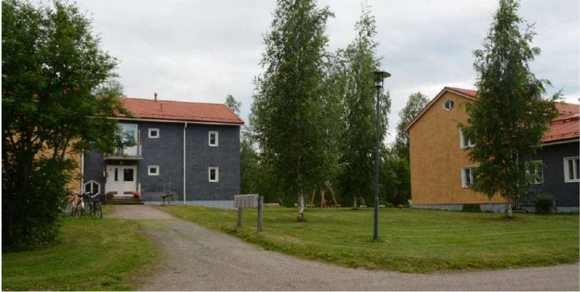
KUVA 19: Rakennukset A ja B kuvattuna idästä.
