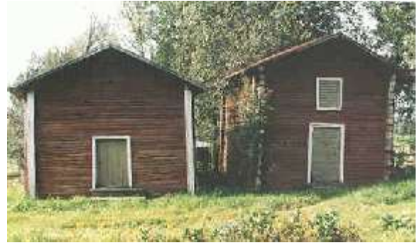
Puolakan aitat. Ulokkeettomia, kaksikerroksisia eloaittoja rakennettiin alueella 1800-luvulla.
