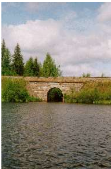
Kivirakenteinen rautatiesilta Niemisjärven Hirvilahden suulla. (Kuva Leila Kantonen)
