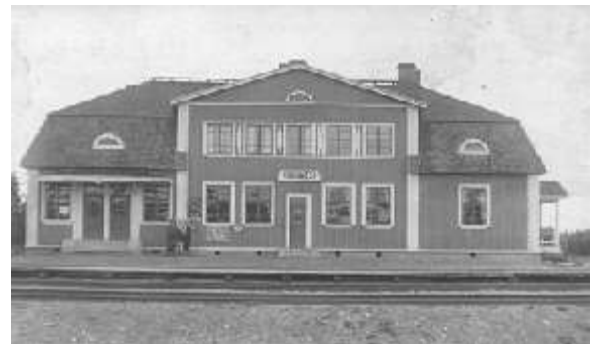
Kiuruveden asemarakennus. (Kuva Kiuruveden kotiseutuyhdistys)
