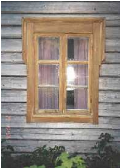
Toiviaiskylän Pölkkyän 6-ruutuisissa ikkunoissa on tavoiteltu T-karmin arvokkuutta. Ylimmät ruudut on erotettu paksummin pienoin.
