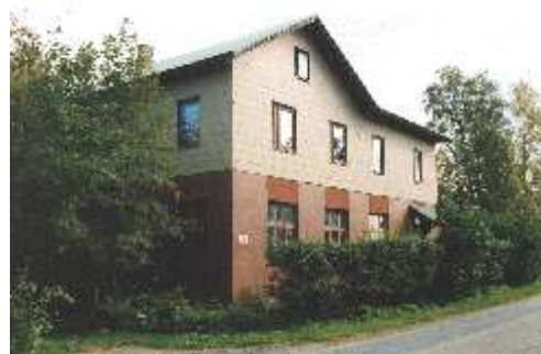
Niemiskylän osuusmeijeri rakennettiin vuonna 1914. Ensimmäisen kerroksen rakennusaineena oli uusi rakennusaine, betoni.
