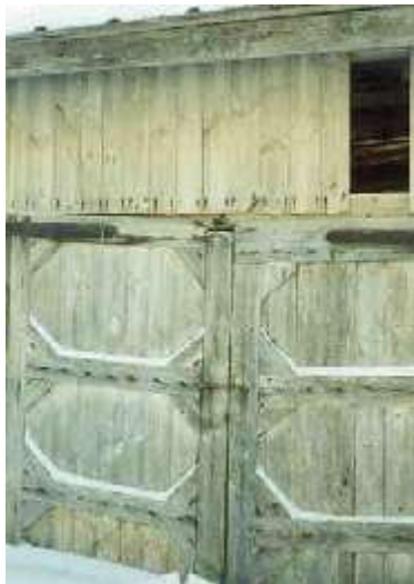
Savossa tyypillinen lautoaven rakenne on koristeellinen tapulin ovelta.
