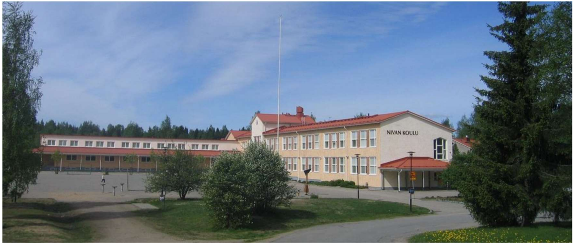
KUVA 18: Nivan koulu. Kuvalähde: Kiuruveden kaupunki, kuvaaja ei tiedossa.
