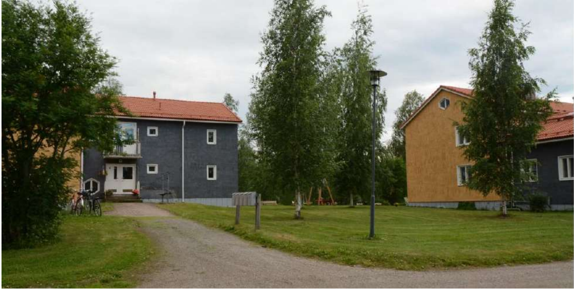
KUVA 19: Rakennukset A ja B kuvattuna idästä.
