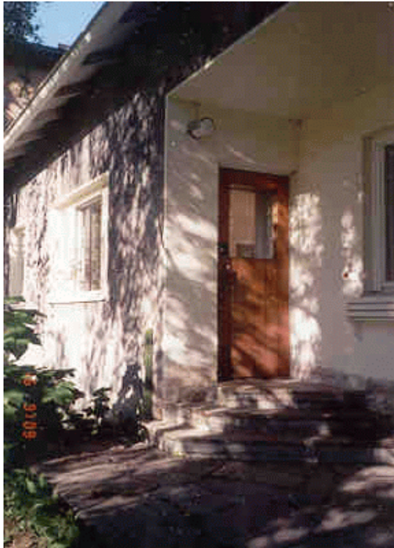
Lahden tilalta Luupuvvedeltä kotoisin ollut arkkitehti Aarne Timonen suunnitteli Kiuruvedelle useiden julkisten rakennusten lisäksi myös asuinrakennuksia ja tyyppitalomalliston Kiuruvedelle. Yllä Nivan ala-asteen opettajien asuinrakennus.
