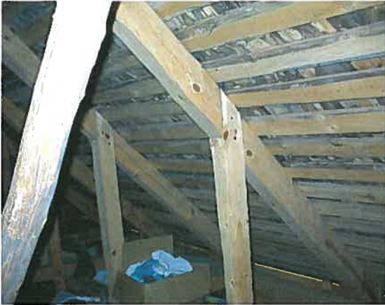
Vesikaton kantavat puurakenteet ovat hyväkuntoisia
