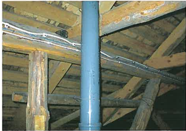
Viemärin tuuletusputki tulee eristää ullakolla
