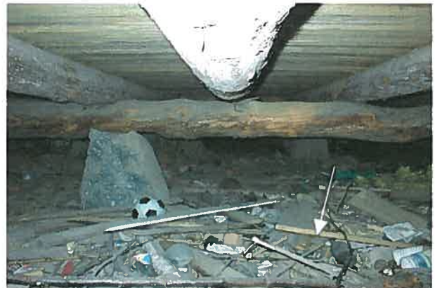
Ryömintätilassa on sinne kuulumatonta tavaraa, kuten puuta ja roskaa
