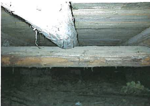
Puurakenteet ovat hyväkuntoisia.
