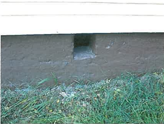
Vanhan osan rossipohjan tuuletusaukkoja
