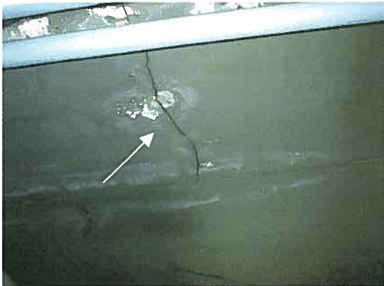
Kattilahuoneen katon osastointi tulee tarkistaa
